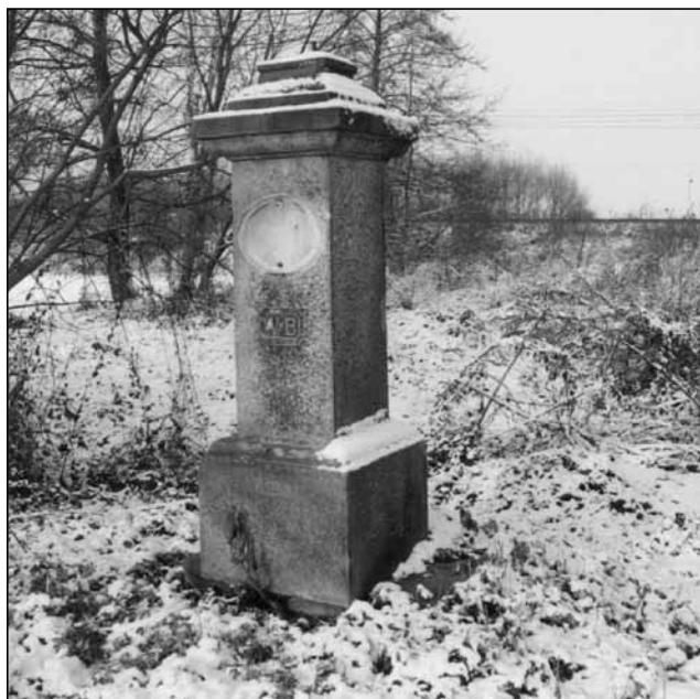
Torzo kříže před opravou (Foto Radim Jarošek)
